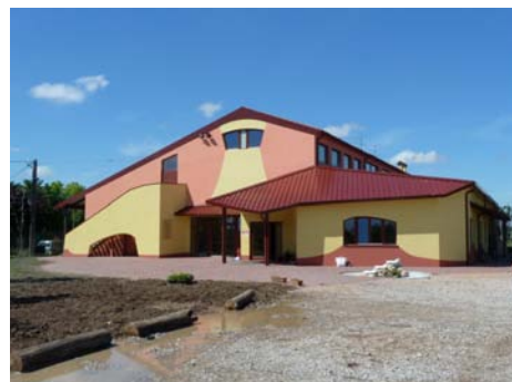
FIGURA 2. La facciata dell'edificio dopo la ristrutturazione.
