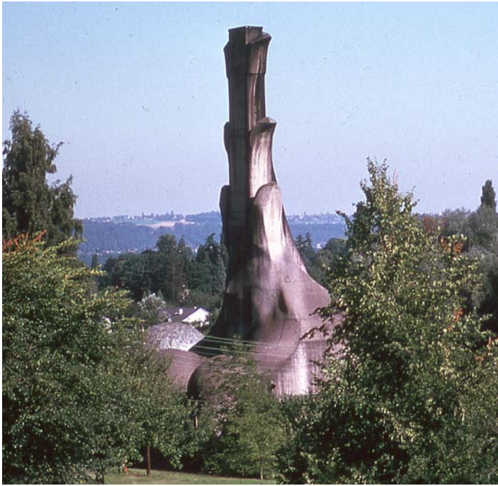
FIGURA 6. Rudolf Steiner, Centrale Termica, Dornach, Svizzera, 1914-1915. Vista da sud.
