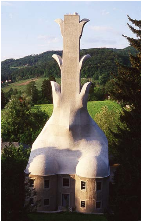
FIGURA 3. Rudolf Steiner, Centrale Termica, Dornach, Svizzera, 1914-1915. Vista da sud-est.
