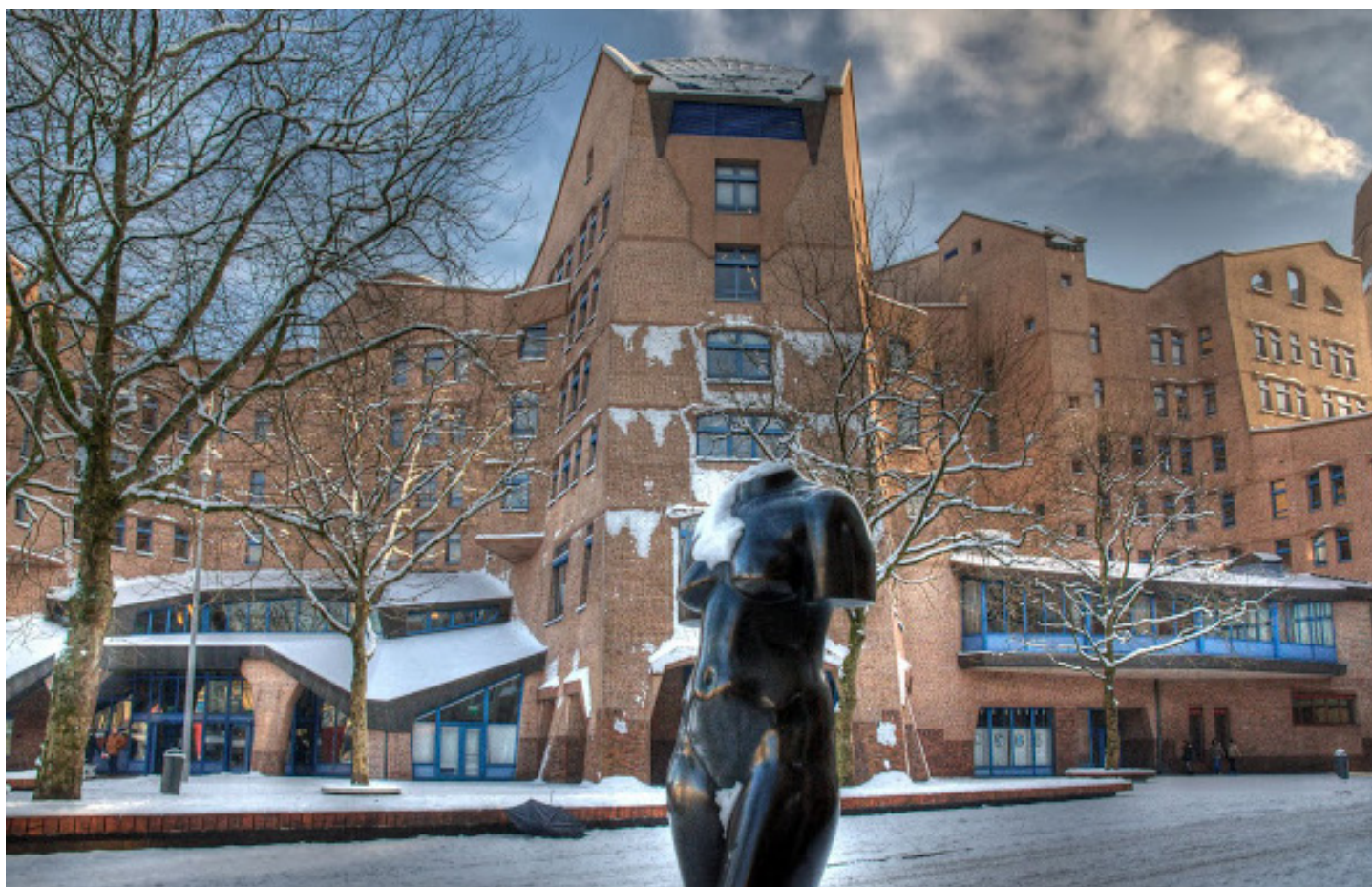
FIGURA 3. Veduta del complesso della Banca ING dalla Abcouderpad (Bijlmerplein).
